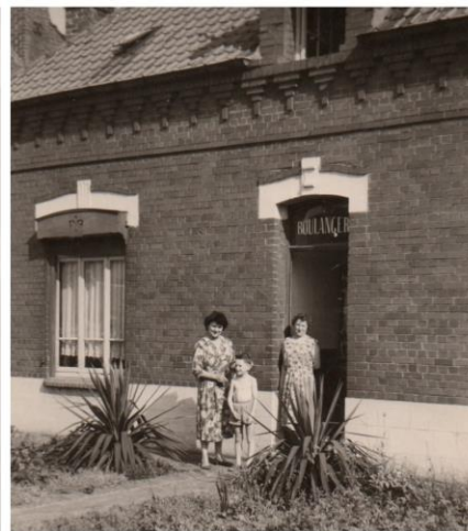
Façade de la Boulangerie au 10 rue Pasteur
